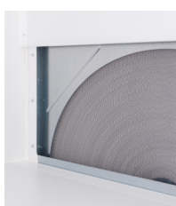
Rotorvärmväxlare
