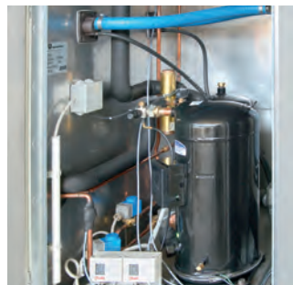
Kylmodulsektion med kompressorer
