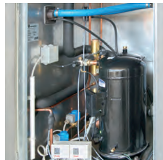
Kylmodulsektion med kompressorer
