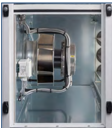
Högeffektiv fläkt EC-motor, steglös, tryckstyrd
